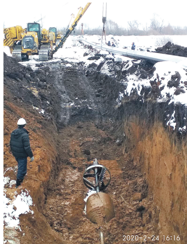
Наклонно-направленное бурение при прохождении водной преграды. Сохранены берега и фауна водоема.
