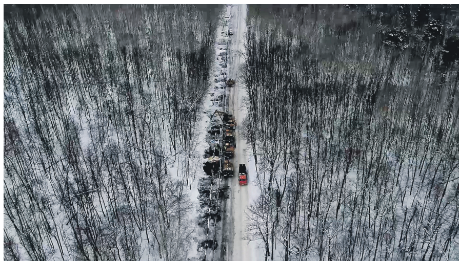
Работы в узком коридоре коммуникаций. В 2021 году он будет замощен железобетонными плитами.
